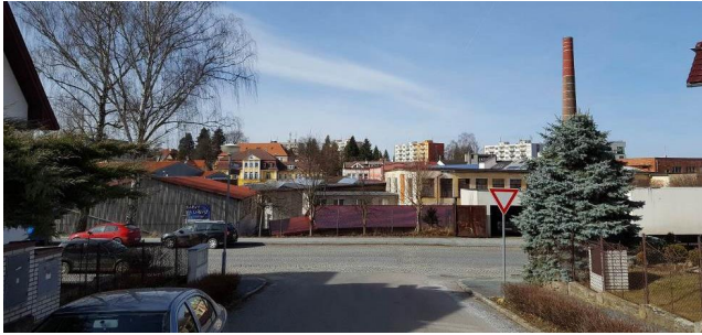
Průhled z ulice Jiráskova na Domov sv. Bronislavy přes řešené území
