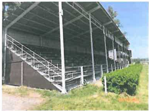
tribuna dostihového závodiště na p.č. St. 2004
