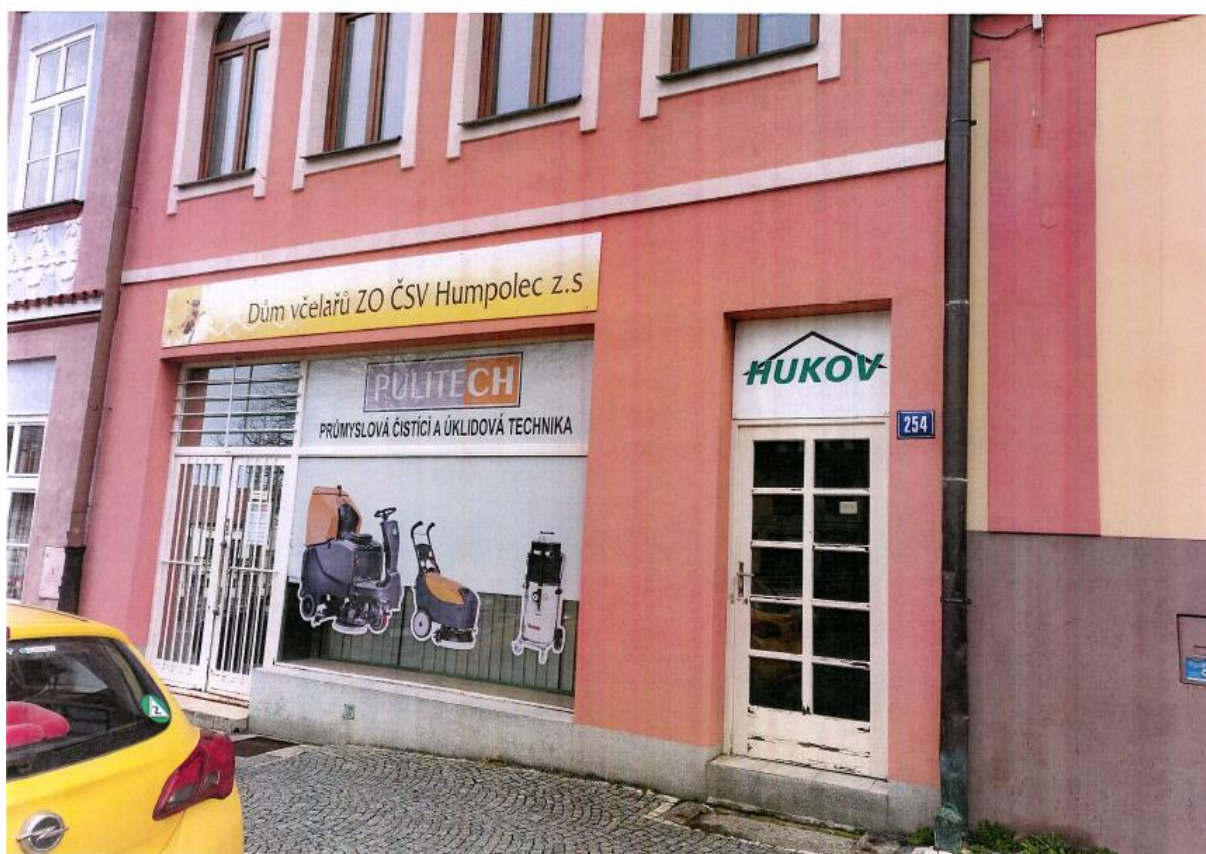
č.p.254 - stav před realizací
