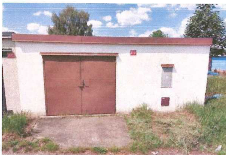
Na parcele 1120/10 a St. 4494 je postavena garáž ev. č. 715
