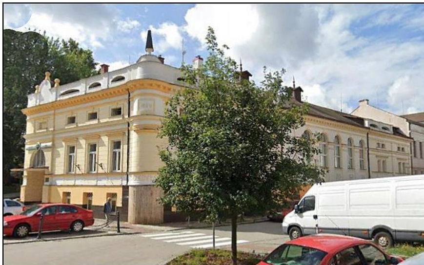
Pohled na budovu od jihovýchodu z nároží ulic Smetanova a Soukenická
