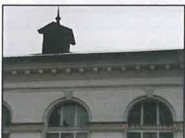
Detail zdobené římsy
