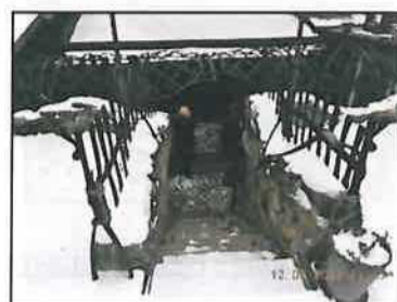
Shody pro vstup do suterénu přístavby
