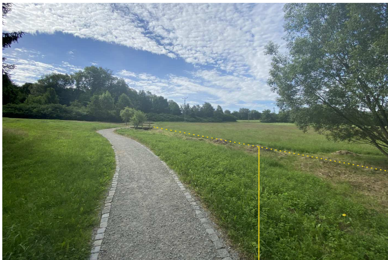
koryto potůčku ze studánky do jezírka - zatrubněno
