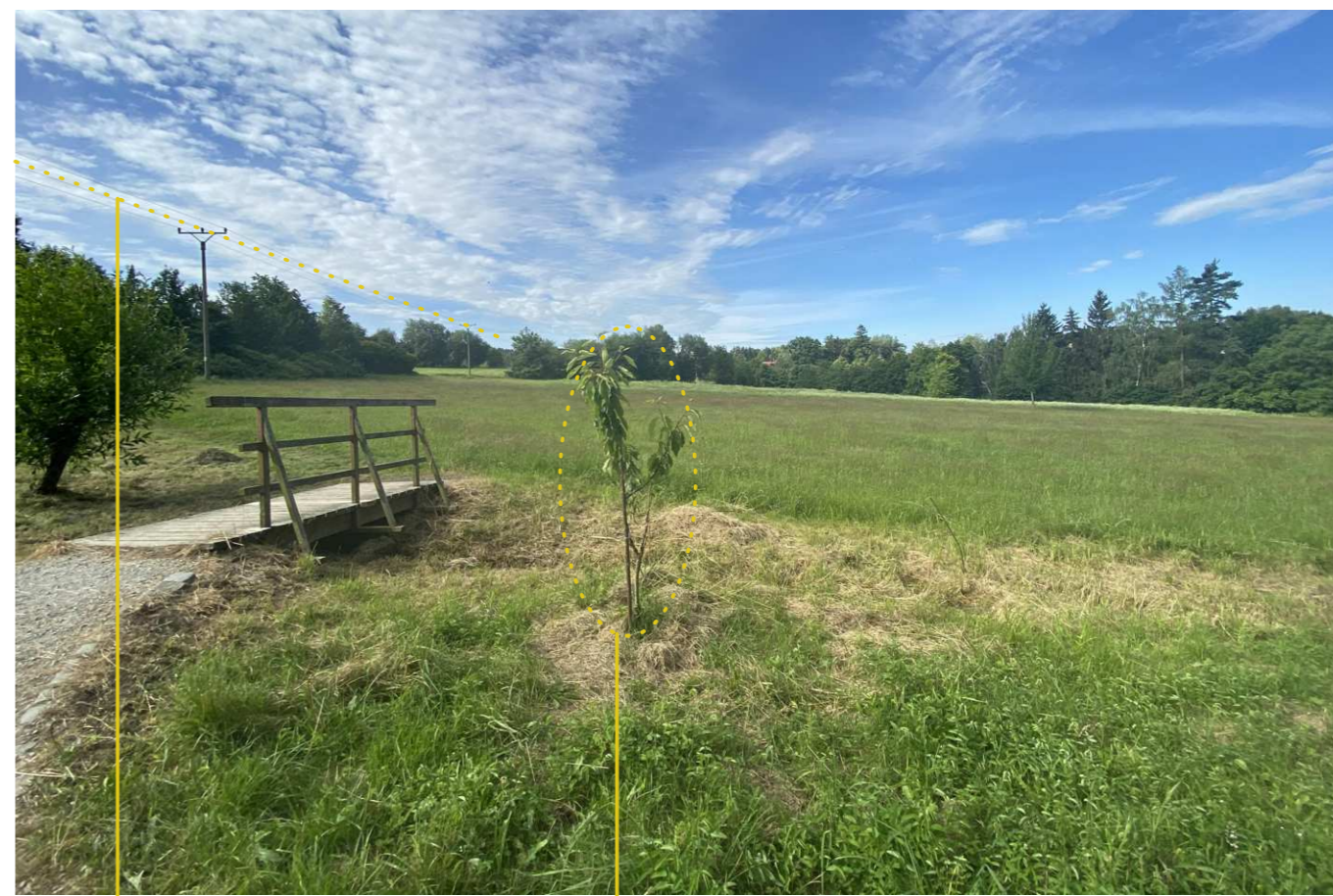
vzdušné vedení VN 22kV
