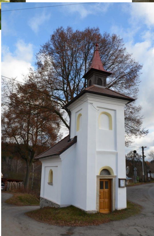
Oprava kapličky v obci Staré Bříšťě
