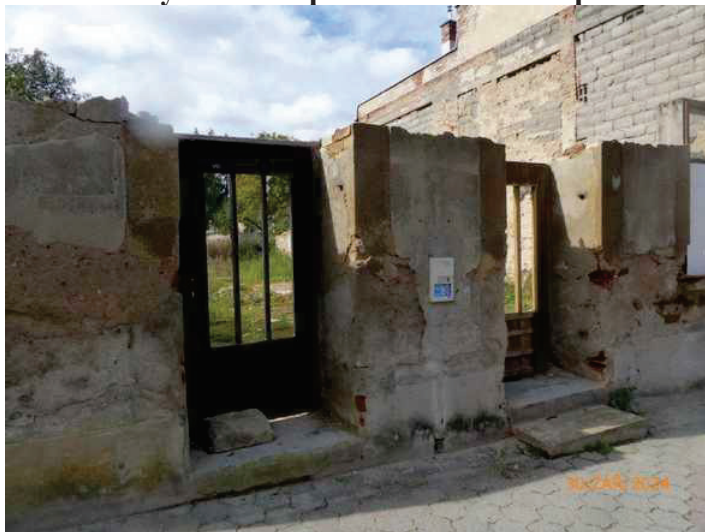
ohradní zeď slouží k zamezení přístupu na parcelu
