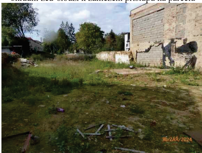
rovná plocha po provedení demolicе původního domu čp. 131
