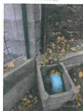
dešťová kanalizace z lokality- DN 200- p.č. 474/4
