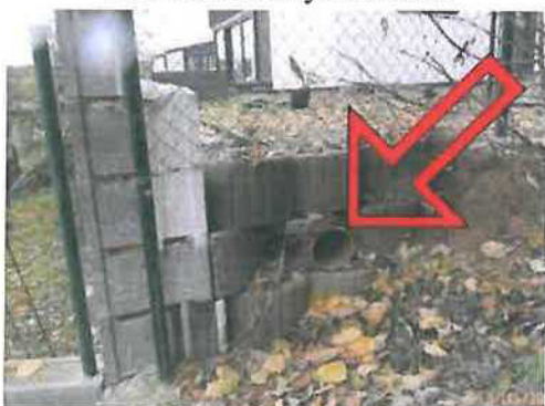
vyústění dešťové kanalizace na p.č. 474/4
