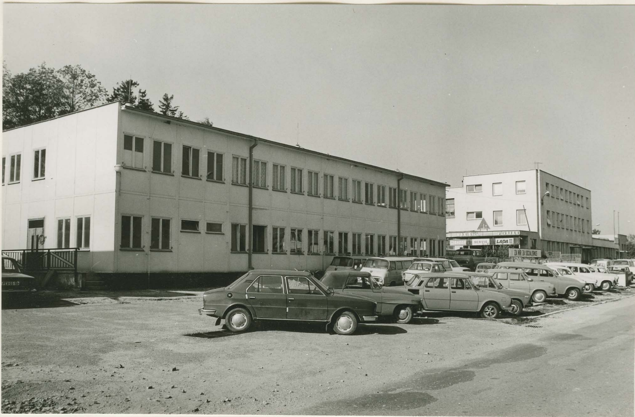
Lužická ulice. Moderní závod ČSAO, opravna vozů Škoda a Žiguli. Výstavba nákladem 20 mil. Kčs, v roce 1970
