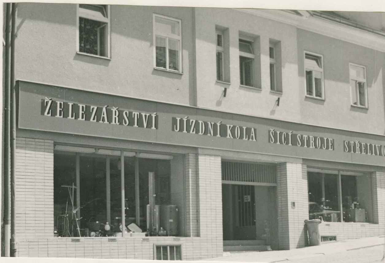
Ulice 1. máje - nově upravená průčelí obchodů
