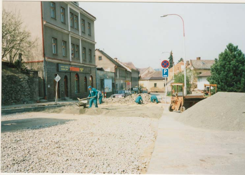
Rekonstrukcia ulice 5. května
