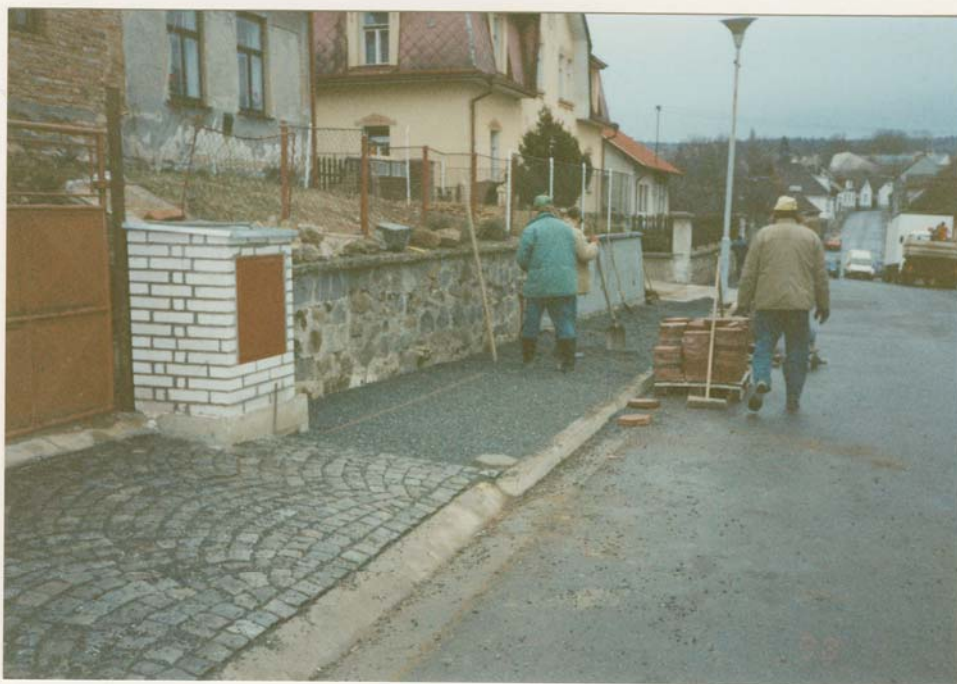
Rekonstrukce ulice Panskodomska'
