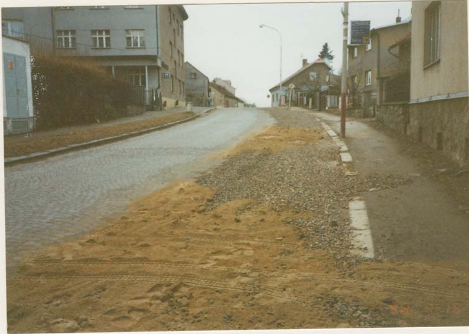
Rekonstrukce ulice 5. května
