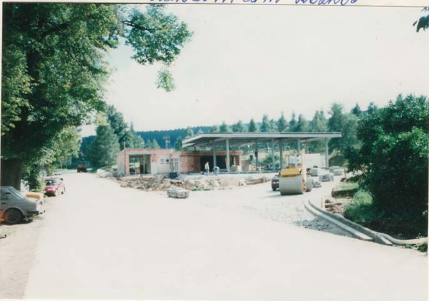
Rekonstrukce výhledové zastávky ul. S. Krátkého
