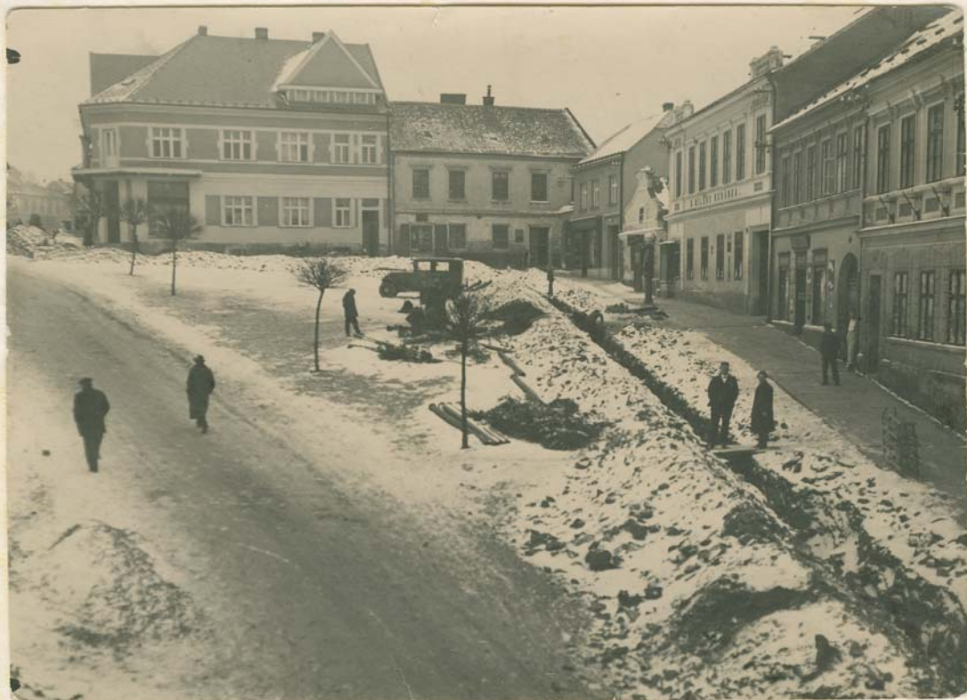
Dolní náměstí před stavební úpravou
