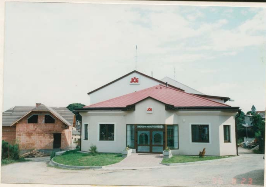
Stavba kancelář Jihočes. energet. v Praze
