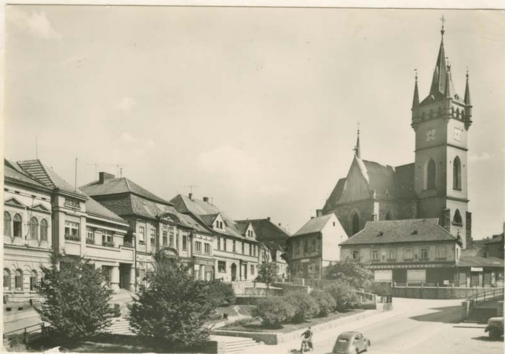
Po stavební úpravě
