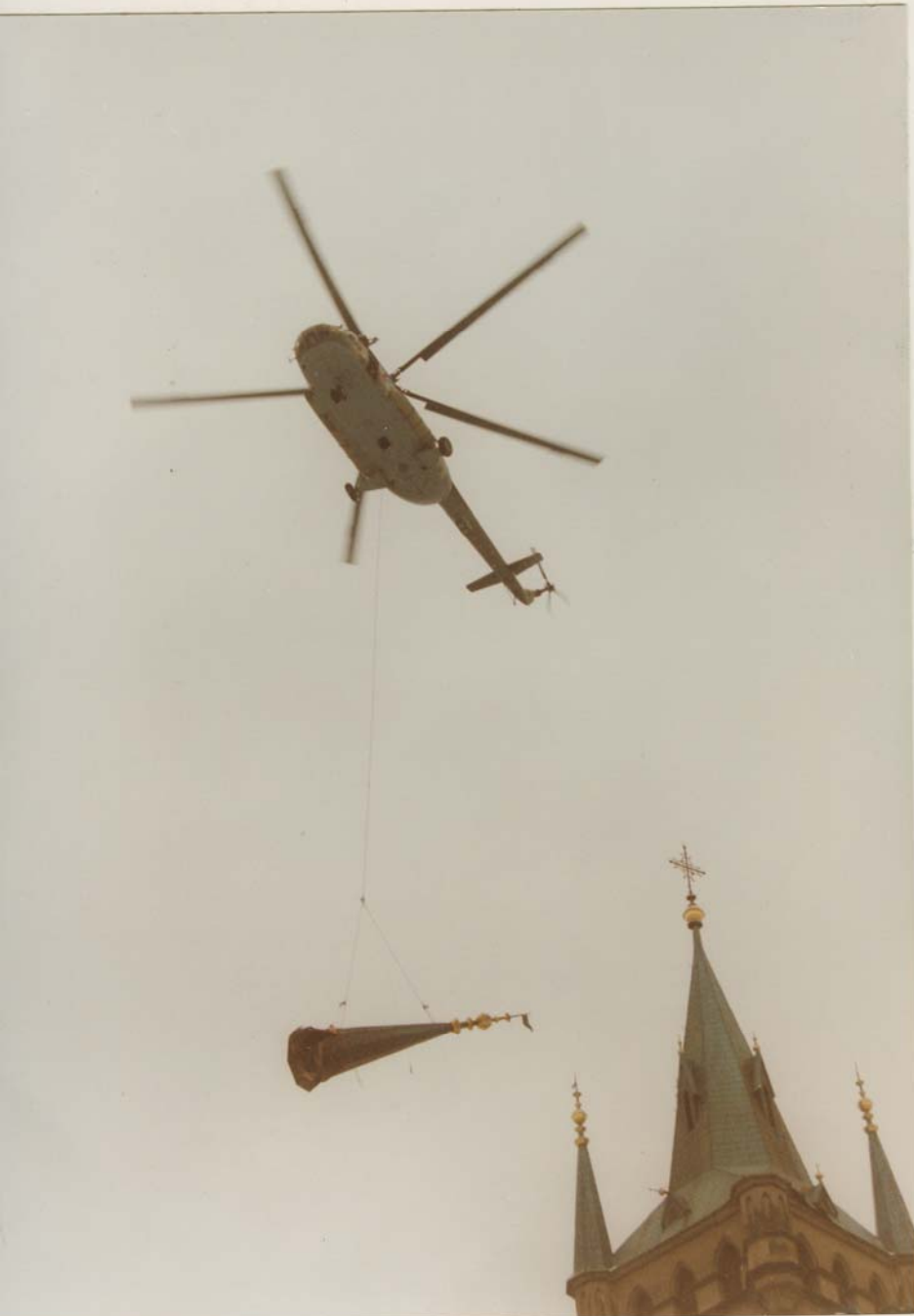
Odvážení věžičky a oprava věže - stavba lešení
